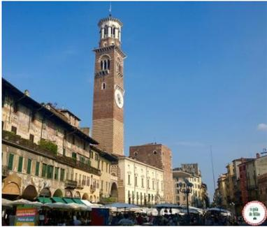
Construída com tufo, mármore e tijolos, a torre de 84 metros remonta a 1464 e a finalização, com a instalação do grande relógio, a 1779.
